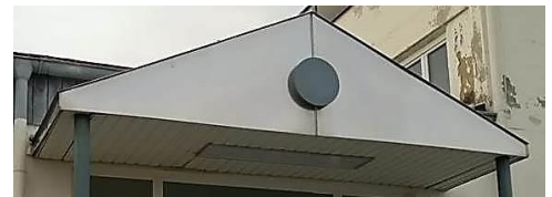
Eingangsbereich der Möbelfabrik Thonet In Friedbreg; Oststeiermark (Foto:Autor)
